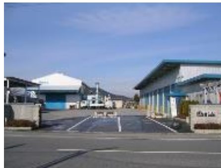
技術センター Technical Center
